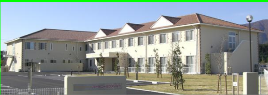
ハーモニーハウスいなべ 介護付有料老人ホーム(50床)
