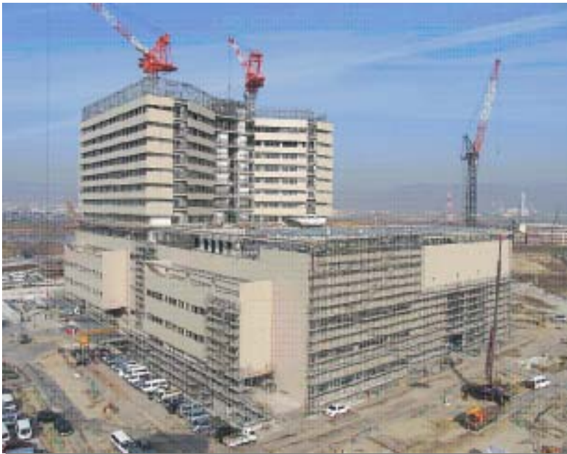
【建設中の関西医科大学附属病院】
